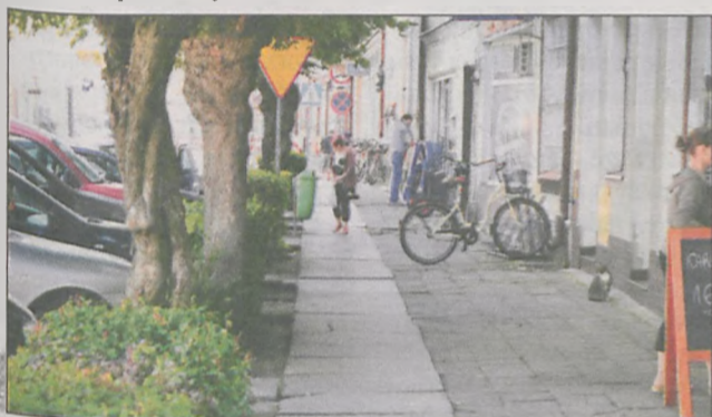
Chodnik do remontu
