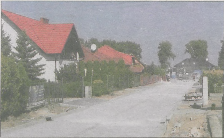
Część ulicy już wyłożono kostką
