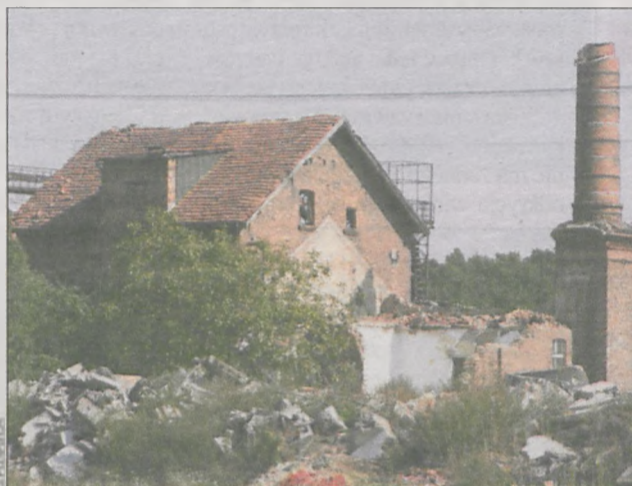
Komin został częściowo rozebrany
