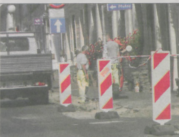
Prace nie powodują na razie utrudnień w ruchu drogowym
