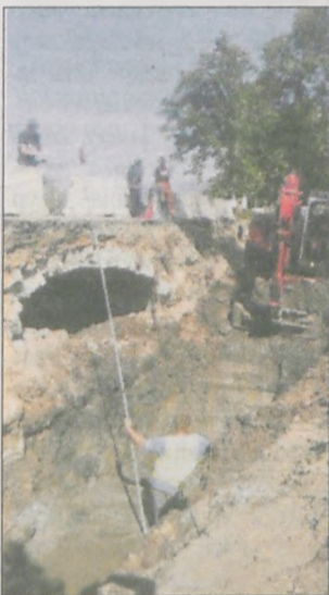
Po tych pracach rozebrany zostanie stary most
