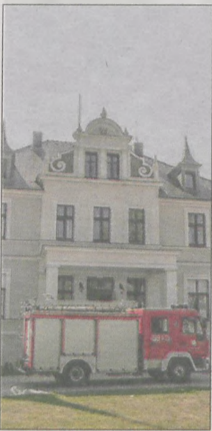
Strażacy sprawdzili obiekt
