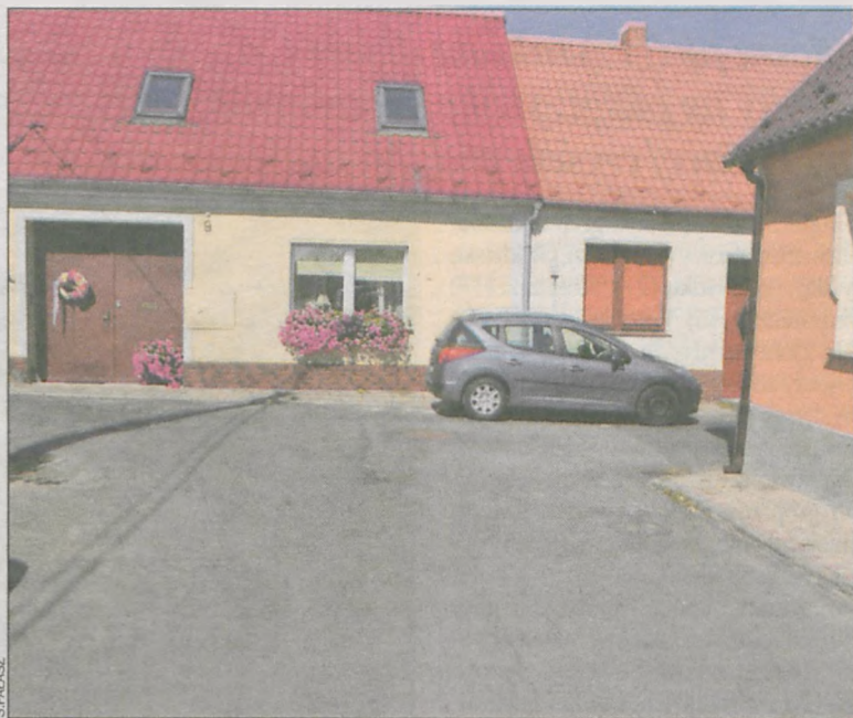
Dach domu na rogu ulicy (z prawej strony) został uszkodzony
