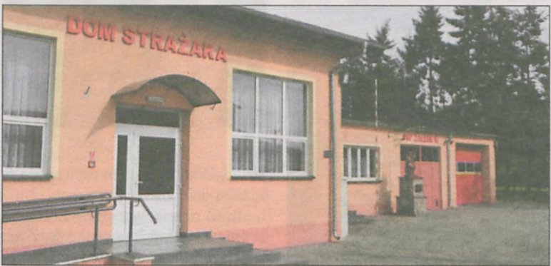
Plac zabaw w Zalesiu Wielkim powstanie przy Domu Strażaka
