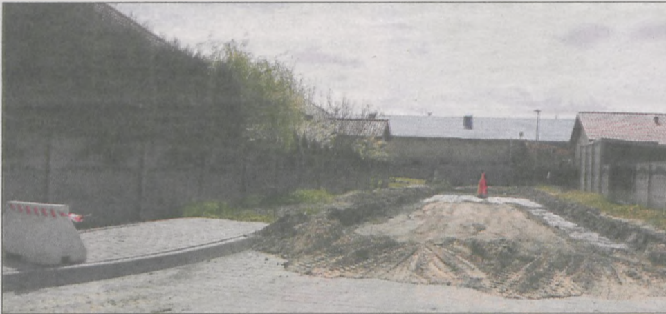
Właśnie rozpoczęto drugi etap przebudowy
