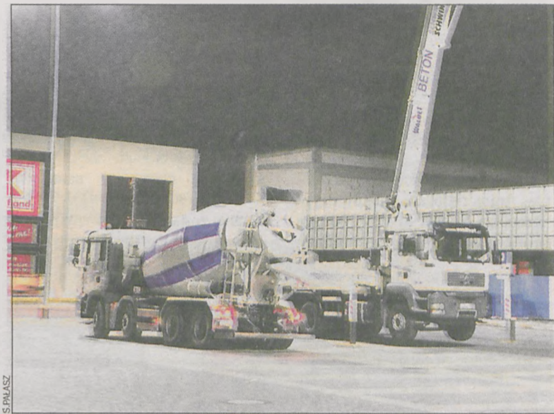
W trakcie prac budowlanych. Listopad 2015 r.
