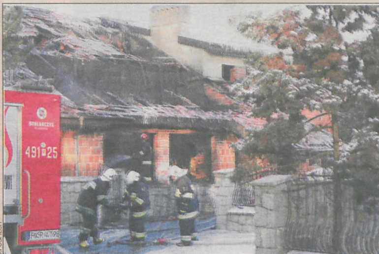
Strażacy usunęli nadpaloną wieżbę dachową na zewnątrz
