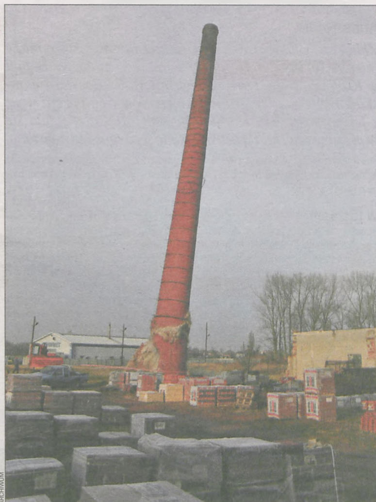
49 m komin fabryki przewrócono w grudniu 2011 r.
