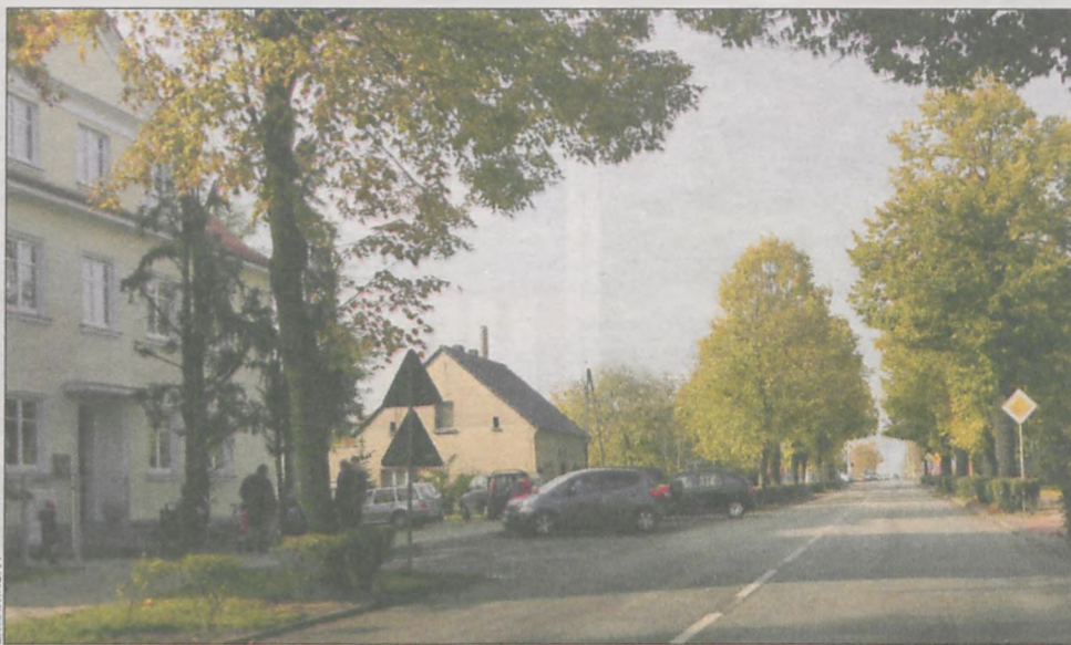
Przy nowym przedszkolu powstanie zatoka autobusowa oraz przejście dla pieszych
