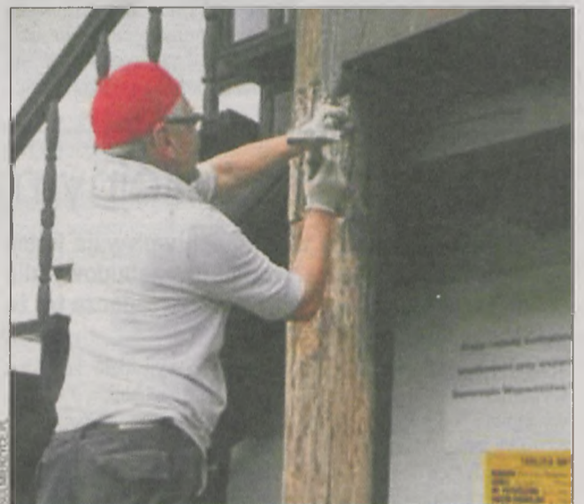
W trakcie prac renowacyjnych
