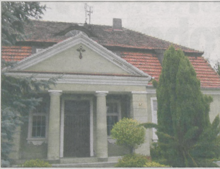
Budynek probostwa z zewnątrz nie wygląda na zaniedbany
