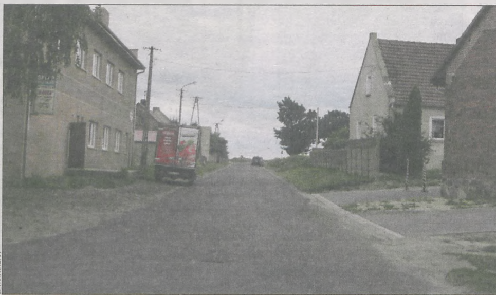
Przy wjeździe do Gościejewa od Mokronosa znajduje się niebezpieczny zakręt. Przejście na przystanek autobusowy jest niebezpieczne dla pieszych, zwłaszcza tych najmłodszych.
