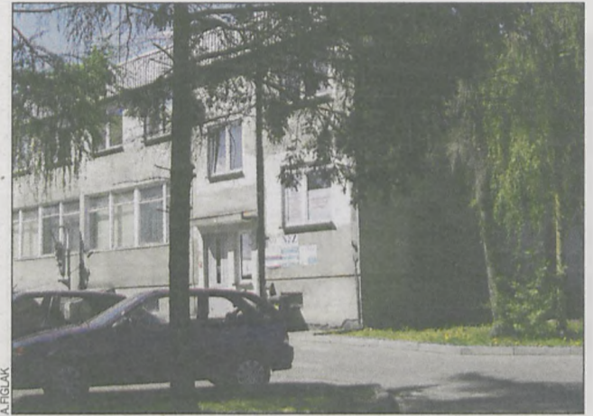
Budynek musi przejść remont do końca przyszłego roku
