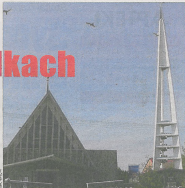
Najważniejsza część dachu została wyremontowana
