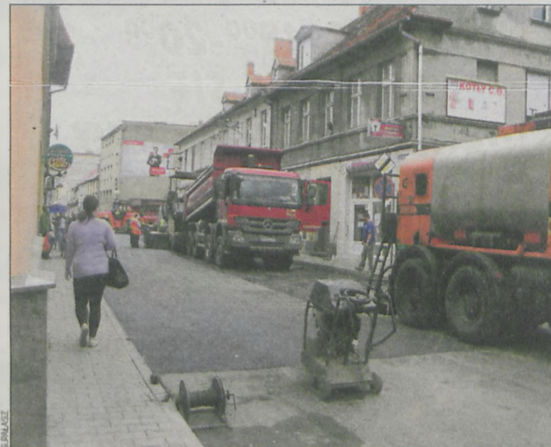
Prace na ul. Piastowskiej w Krotoszynie
