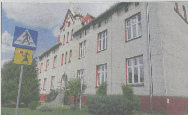
W wyniku zwarcia instalacji elektrycznej zapalił się podgrzewacz wody
