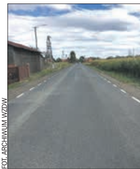
Droga nr 447 po remoncie.
