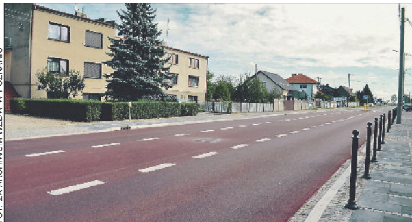
W ramach inwestycji w Sulmierzycach wymieniono m.in. kamienny bruk jezdni na nawierzchnię z betonu asfaltowego o kolorze ceglanym.
