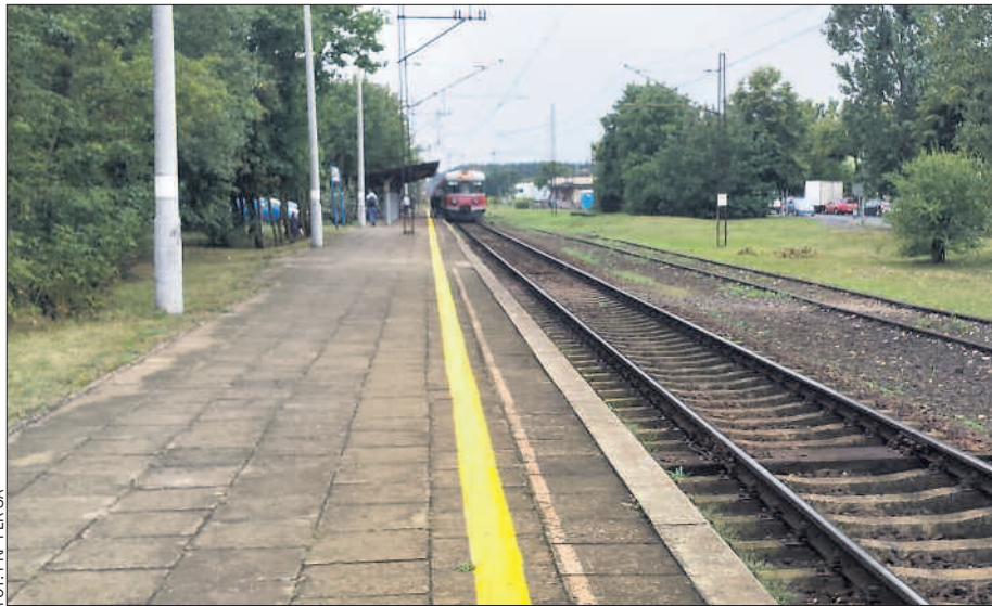
Modernizacja linii zakłada również remonty peronów na trasie. Na zdjęciu peron w Obornikach Wlkp.
