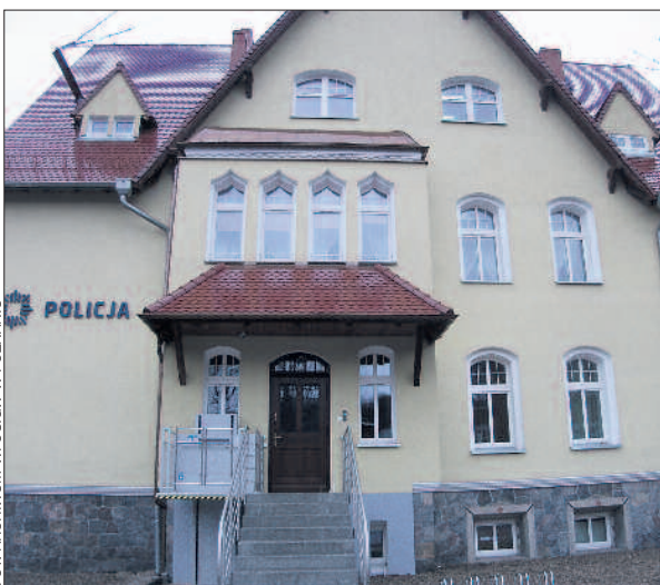
Na zdjęciu budynek policji w Czarnkowie po termomodernizacji, którą wsparło z pieniędzy WFOŚiGW w Poznaniu.
