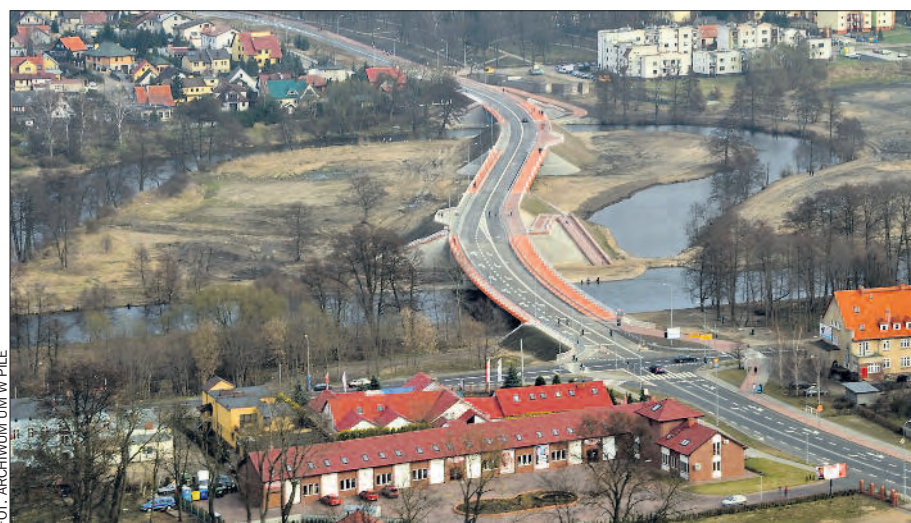
W minionych latach z pieniędzy unijnych wsparto między innymi połączenie drogi krajowej nr 11 i wojewódzkiej nr 188, czyli budowę ostatniego etapu obwodnicy Pity.
