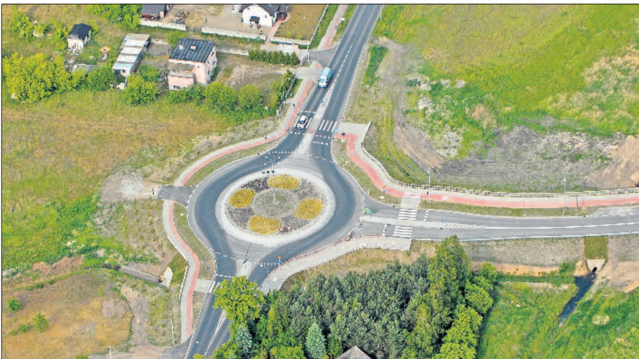
Przy realizacji oddanej w czerwcu do użytku obwodnicy Wągrowca wybudowano m.in. rondo łączące trasę z ulicą Rogozińską.
