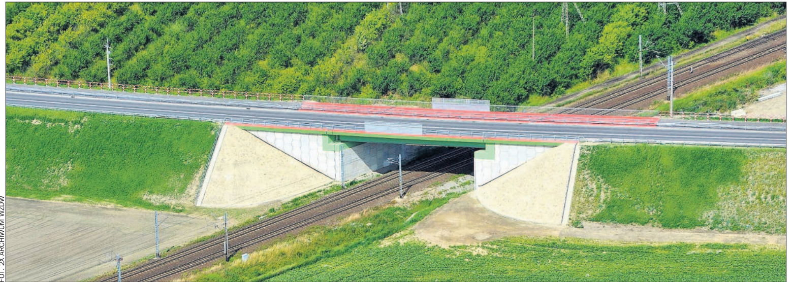
Jedną z inwestycji dofinansowanych z pieniędzy UE była budowa obwodnicy Opalenicy na drodze wojewódzkiej nr 307. Tutaj postawiono na rozwiązanie bezkolizyjne, tj. wiadukt nad torami kolejowymi.
