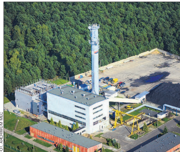
KOTŁOWNIA KOSZYCE ZMNIJSZY W PILE ZAPOTRZEBOWANIE NA ENERGIĘ ZE ŹRÓDEŁ KONWENCJONALNYCH.
