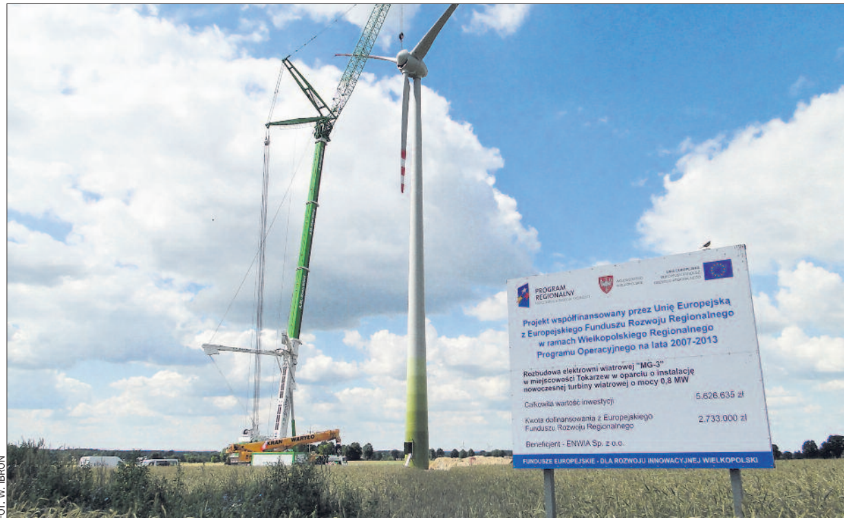
Mimo braku ustawy o OZE, wielu inwestorów stawia kolejne elektrownie wiatrowe. Na zdjęciu montaż wiatraka o mocy 0,8 MW w miejscowości Tokarzew w Wielkopolsce.
