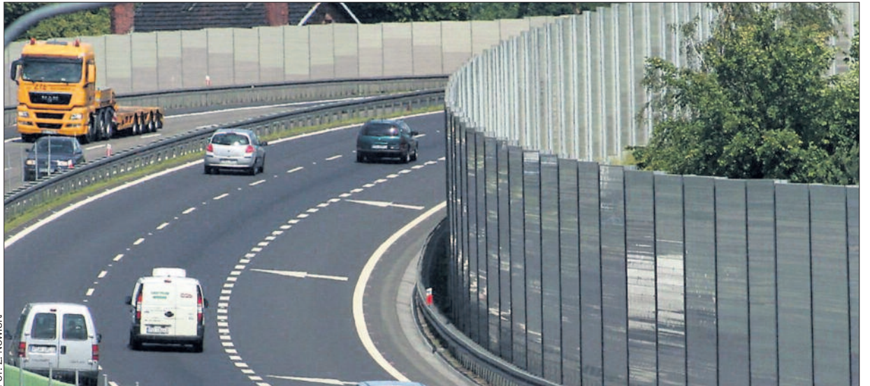
Jednym ze sposobów ochrony przed hałasem pochodzącym z dróg jest stawianie ekranów akustycznych.
