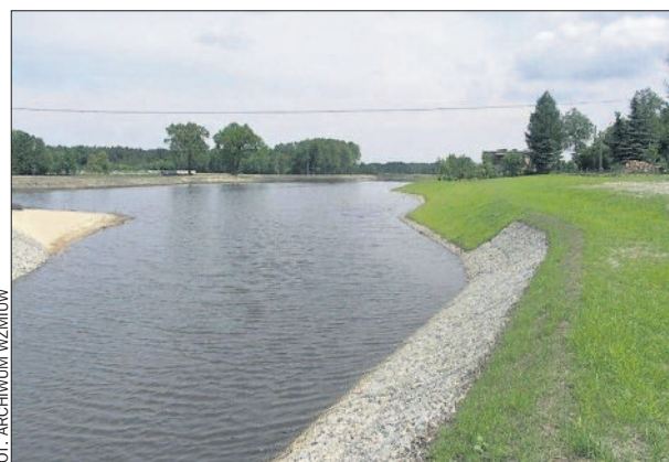
W Wielkopolsce mamy już 34 zbiorniki retencyjne (jak ten w Miedzichowie) pozwalające zmagazynować 60,7 mln m 3 wody.
