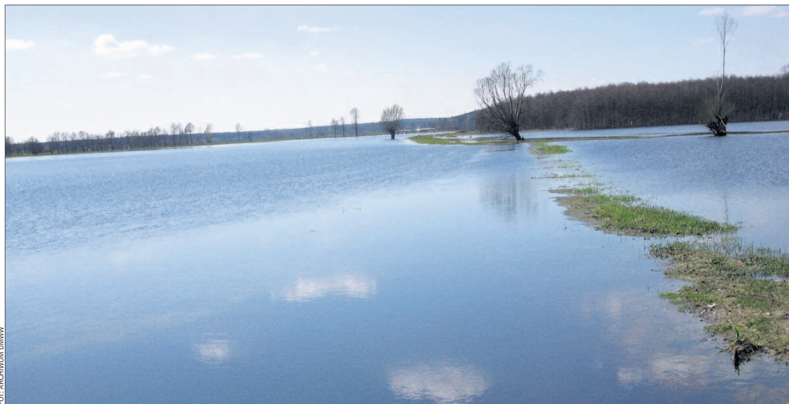
W Wielkopolsce co roku występują lokalne powodzie i podtopienia. Zbiornik wodny w Jaraczewie, którego budowa ma się zakończyć jeszcze w tym roku, poprawi bezpieczeństwo okolicznych mieszkańców, a także uchroni pola uprawne przed zalaniem.
