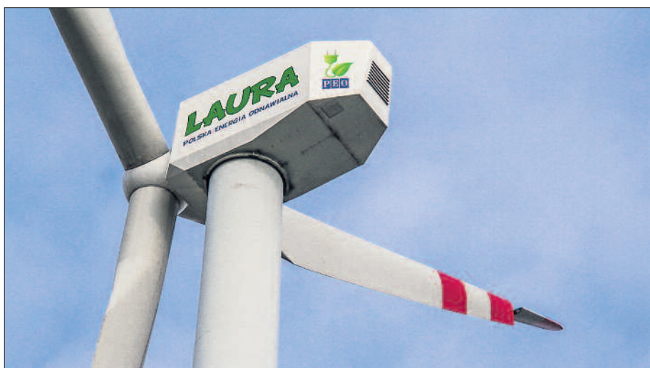
Gondola elektrowni waży 40 ton, a do jej montażu użyto największego w Wielkopolsce dźwigu.
