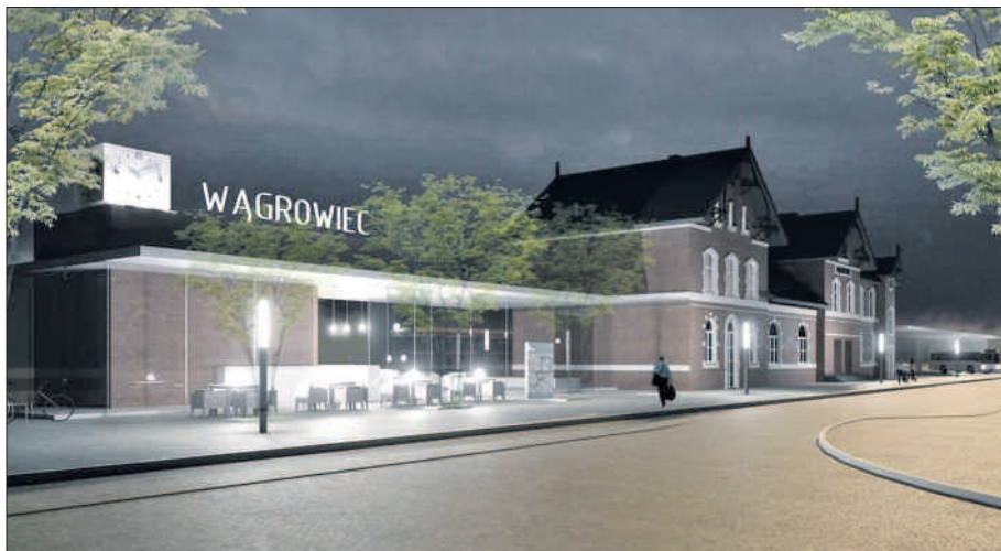
Po zakończeniu inwestycji dworzec w Wągrowcu zmieni się nie do poznania.
