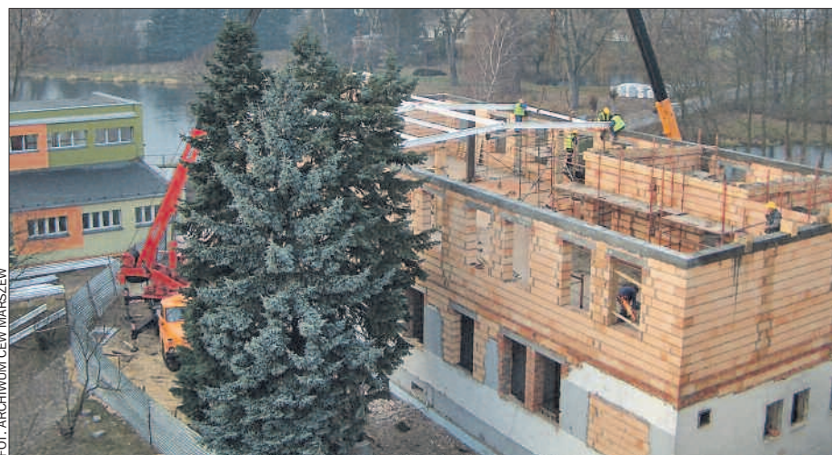
Remont i rozbudowa ośrodka w Marszewie ma się zakończyć w sierpniu 2014 r.
