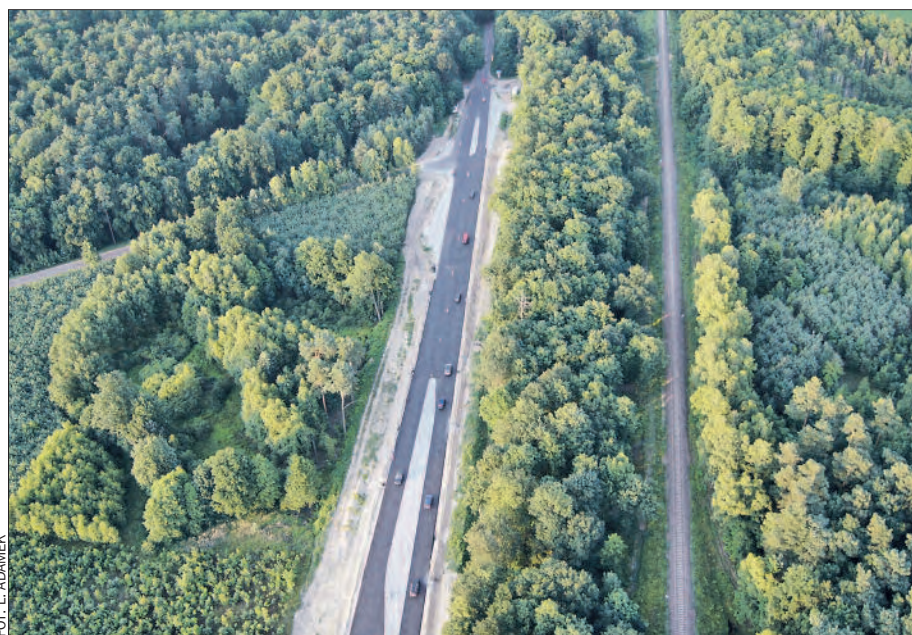
Modernizacja drogi wojewódzkiej nr 196 z Murowanej Gośliny do Wągrowca zostanie zakończona w 2014 r. Wartość inwestycji dofinansowanej z UE przekracza 69 mln zł.
