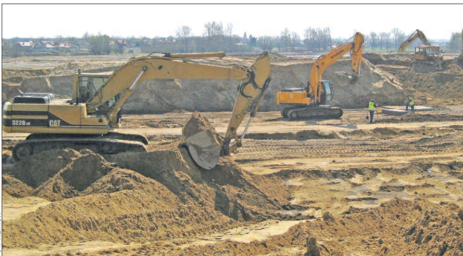
Trwają prace na budowie zbiornika Rydzyna.
