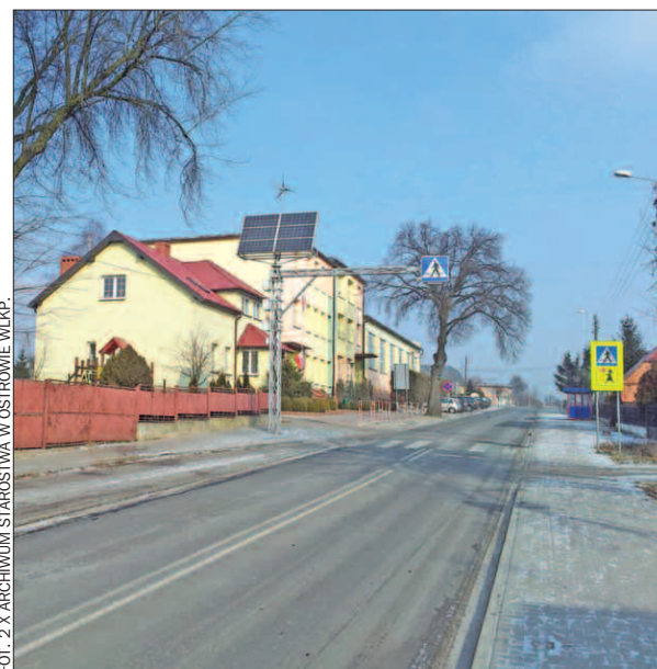
Fragment przebudowanej drogi Przygodzice-Wtórek.
