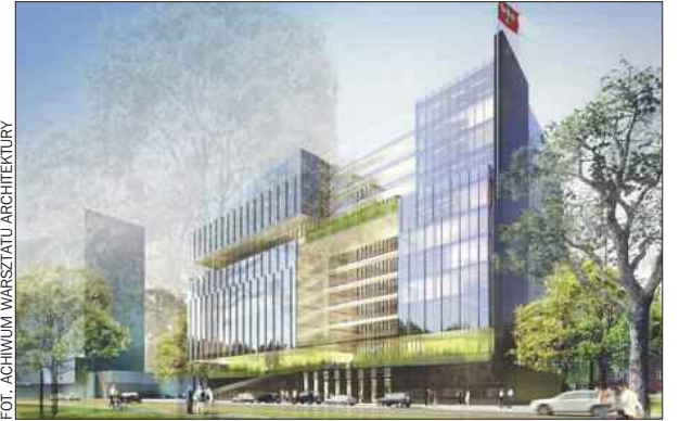
Taki ma być po 30 miesiącach efekt rozpoczynających się właśnie przy al. Niepodległości prac budowlanych.
