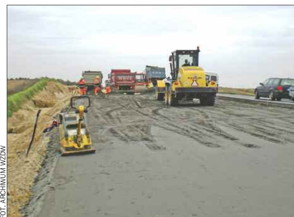
Trwa budowa obwodnicy Murowanej Gośliny.
