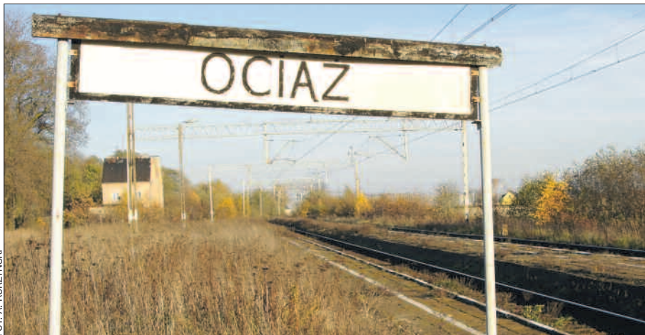
Tak obecnie wygląda przystanek kolejowy w Ociążu. Czy ta niewielka miejscowość stanie się ważnym węzłem komunikacyjnym, w którym linia Kolei Dużych Prędkości rozgałęzi się będzie w kierunku Poznania i Wrocławia?
