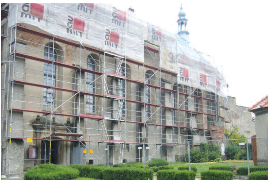
Trwają prace renowacyjne w pobernardyńskim zespole klasztornym w Ostrzeszowie.
