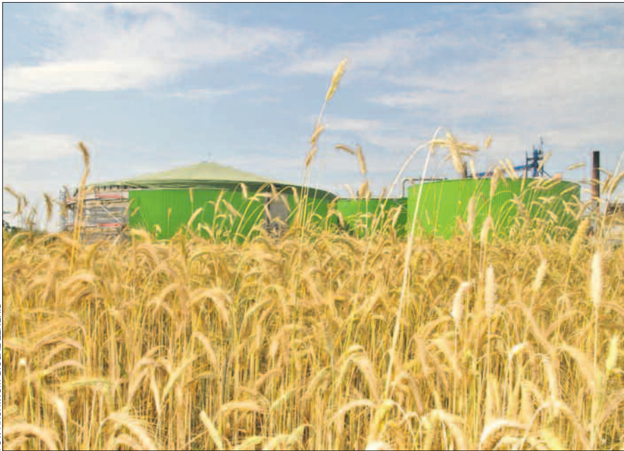
Biogazownia w Skrzatuszu budowana przez firmę Biogaz Zeneris Sp. z o.o.
