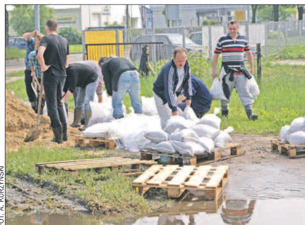
Budowa umocnień na kaliskim Piskorzewiu.
