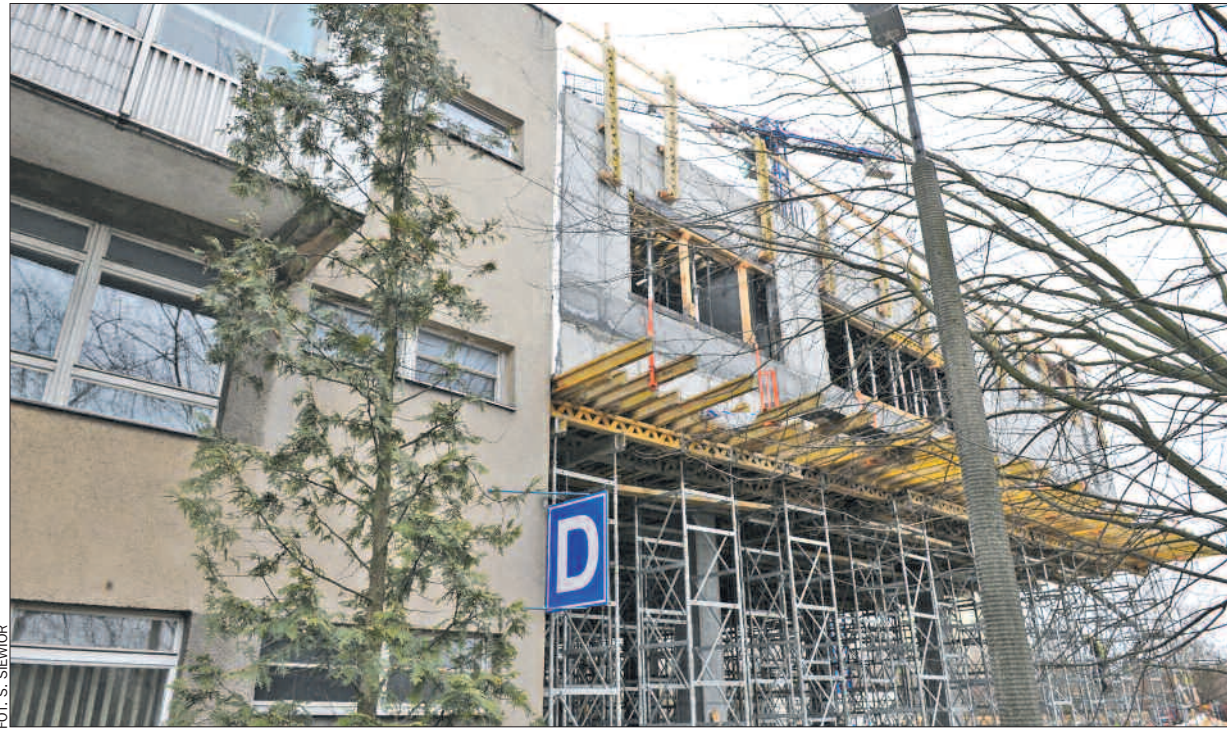
Rozbudowa Szpitala Wojewódzkiego w Poznaniu wzbogaci placówkę o nowoczesny blok operacyjny oraz nowe miejsca intensywnej opieki medycznej.
