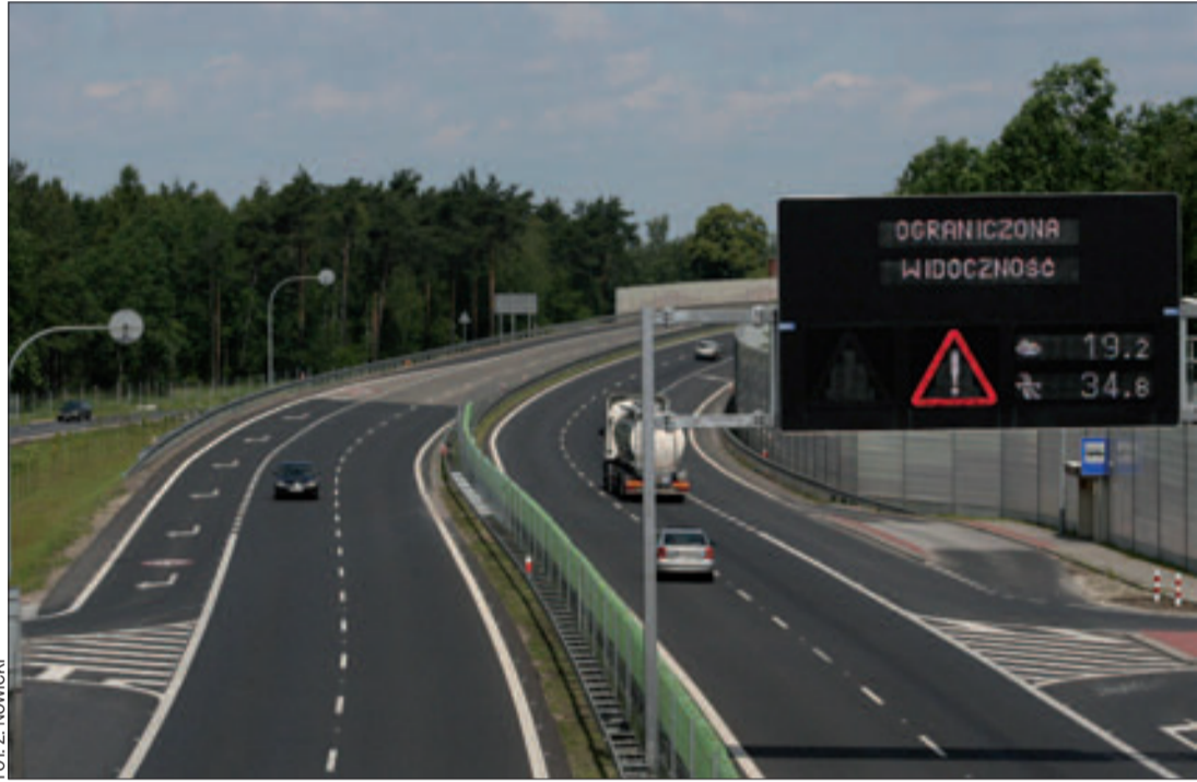
Nowoczesne oblicze drogi nr 11 – ekspresowa „Trasa Kórnicka”.
