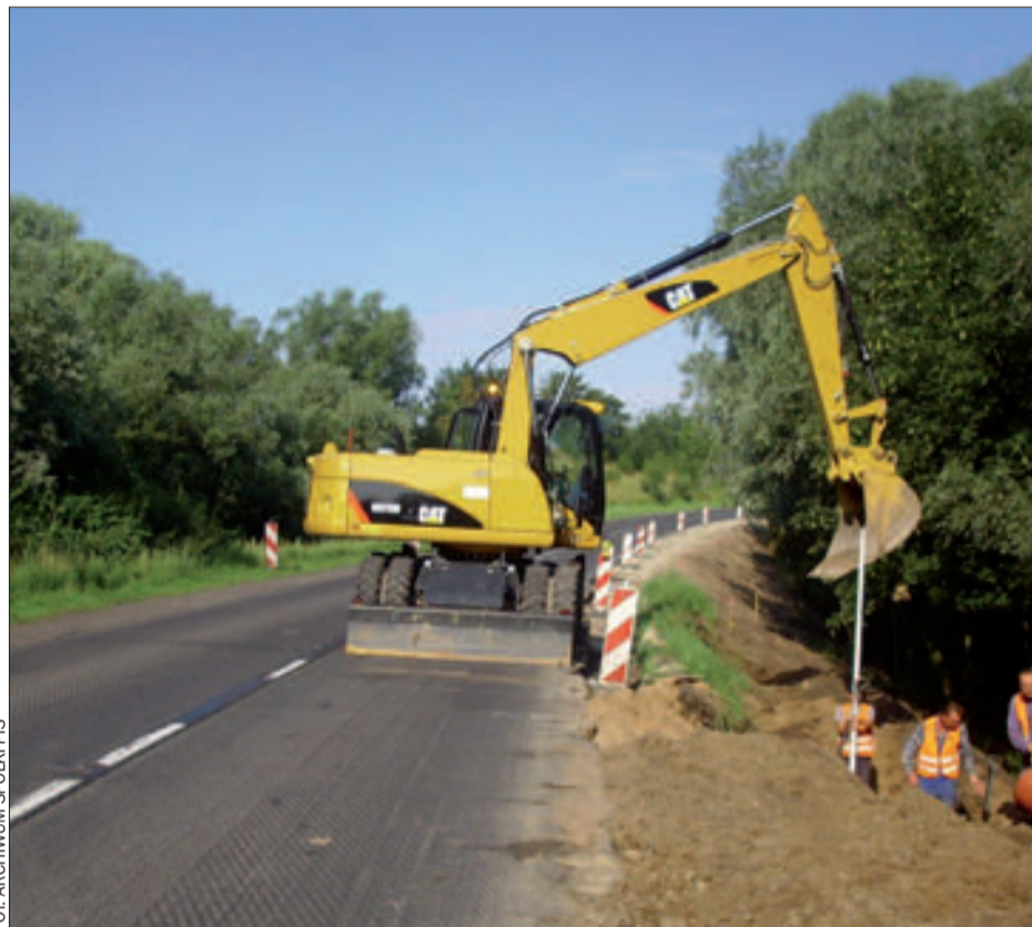
Nowoczesne koparki mogą sprawnie wykonywać roboty na trudnym terenie.
