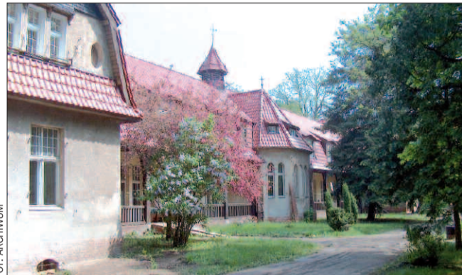
Samorząd sfinansuje projekt termomodernizacji Szpitala Rehabilitacyjno-Kardiologicznego w Kowanówku.
