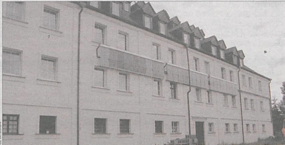
Kolektory słoneczne na budynkach klasztoru w Łądzie
