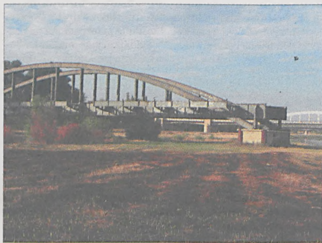
Najwyżej sklasyfikowana została budowa Mostu Cybińskiego między Śródką a Ostrowem Tumskim w Poznaniu. W konstrukcji wykorzystane zostanie przeszło starego mostu św. Rocha na Warcie.
