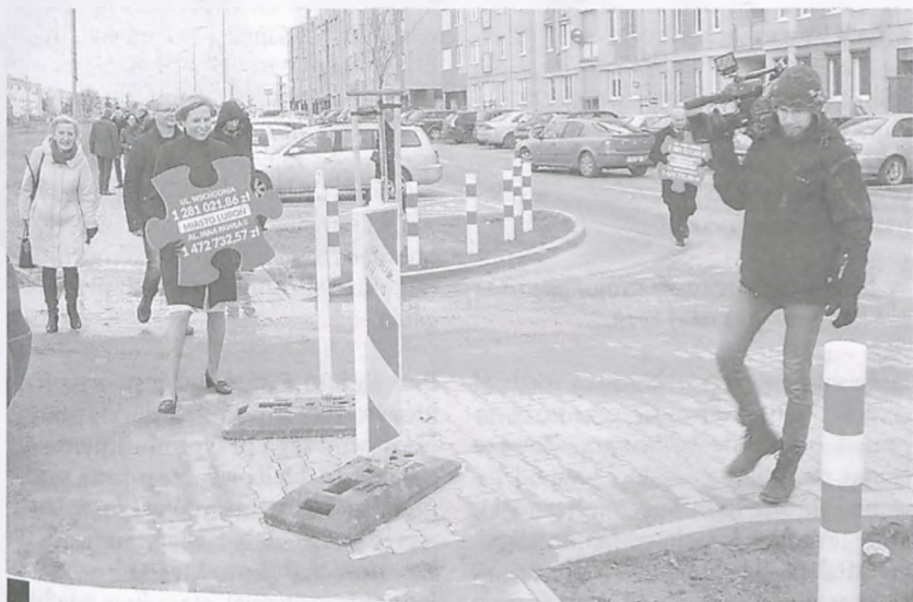
Uchwyceni przez „Wieści Lubońskie” dysonans w drodze pomiędzy rondami. Na skrzyżowaniu nowej inwestycji z ulicą A. Mizerki naniesione, znane w Luboniu błoto, jak widać niestraszne do przejścia dla lokalnych notabli. Ekipa TVP oraz Wojewoda Wielkopolski wycofali się z tej błotnej przeprawy i okrężną drogą (jezdnią) dołączyli do dumnie kroczącego orszaku fot. Piotr P. Ruszkowski
