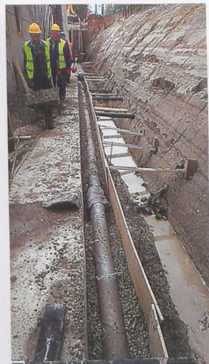
Zgodnie z oświadczeniem inwestora i zdjęciami, które nam przesłał, system drenażowy wokół inwestycji przy ul. Wschodniej 19 jest gotowy fot. arch. NCS-Bud
