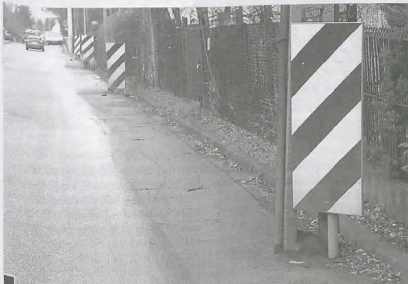
Po śladach samochodów na asfalcie ul. Traugutta widać, jak nieprzesunięte słupy energetyczne zwężają pas jezdni fot. Piotr P. Ruszkowski
