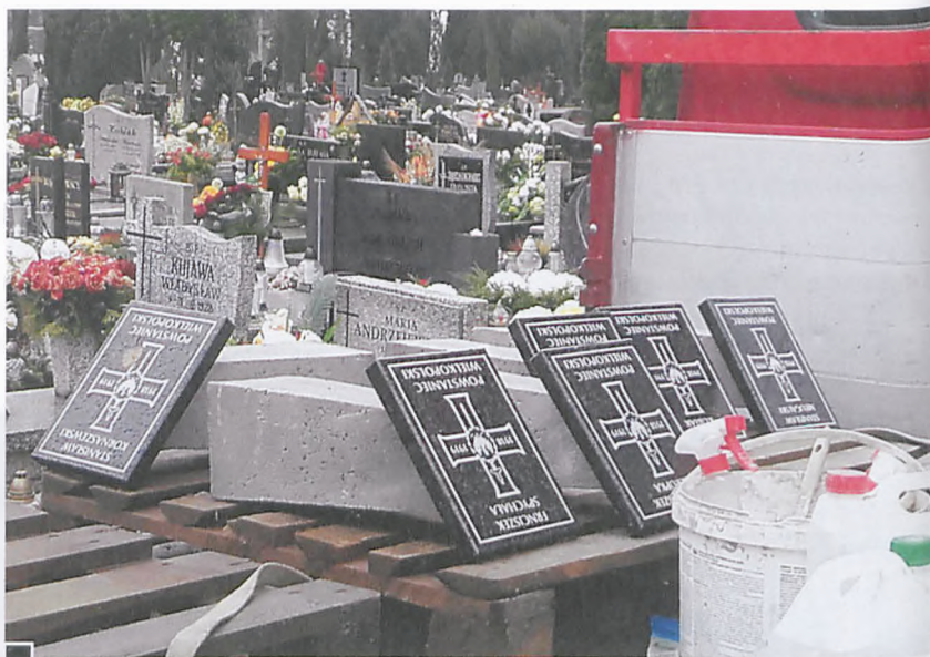
Przygotowane do montażu tabliczki upamiętniające naszych powstańców wielkopolskich na platformie samochodu, na cmentarzu parafialnym w Żabikowie fot. Hanna Siatka
