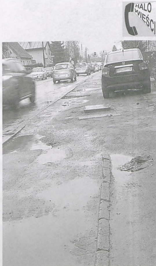
Błoto, kałuże w głębokich dziurach, różnice terenu pomiędzy pozostałościami po asfalcie(?) a gruntem i wystająca studzienka telekomunikacyjna – „chodnik” po nieoświetlonej stronie ul. Sobieskiego, na odcinku od Targowej do Żabikowskiej fot. Hanna Siatka
