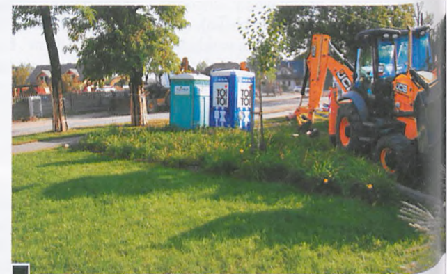
Fragment zagospodarowanego w 2014 r. skweru „Sąsiedzkie tulipany”, który przy wariacie z ul. Długą zostanie wydzielony, wykupiony i zamieniony na drogę fot. Piotr P. Ruszkowski
