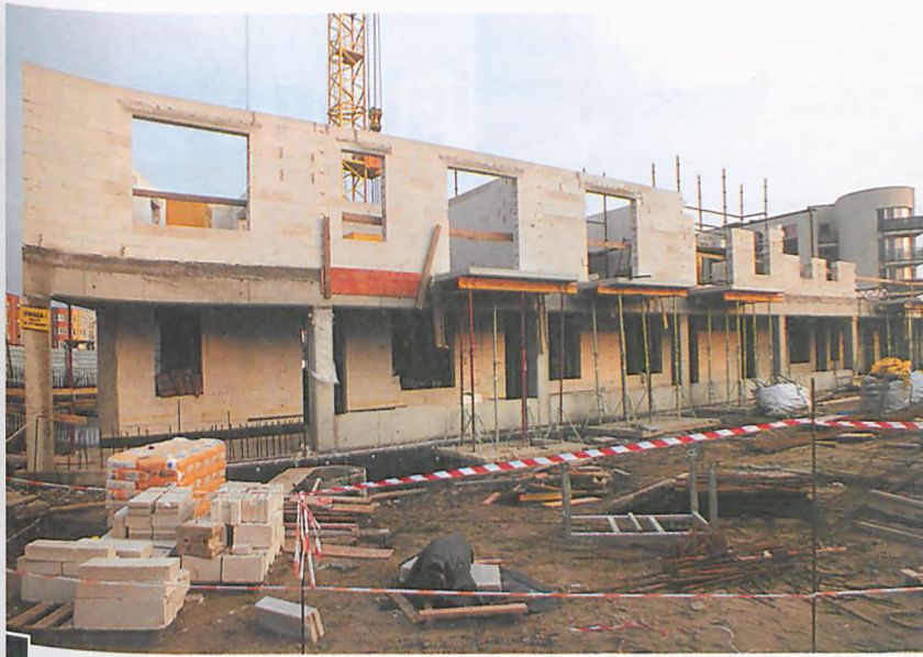
Budowa 4-kondygnacyjnego bloku firmy „Immo-Building” przy ul. Kochanowskiego-Mizerki (adres: ul. Pułaskiego 16A). Na przyziemiu w przyszłości, pod podcieniami, będą funkcjonować lokale usługowe fot. Hanna Siatka
