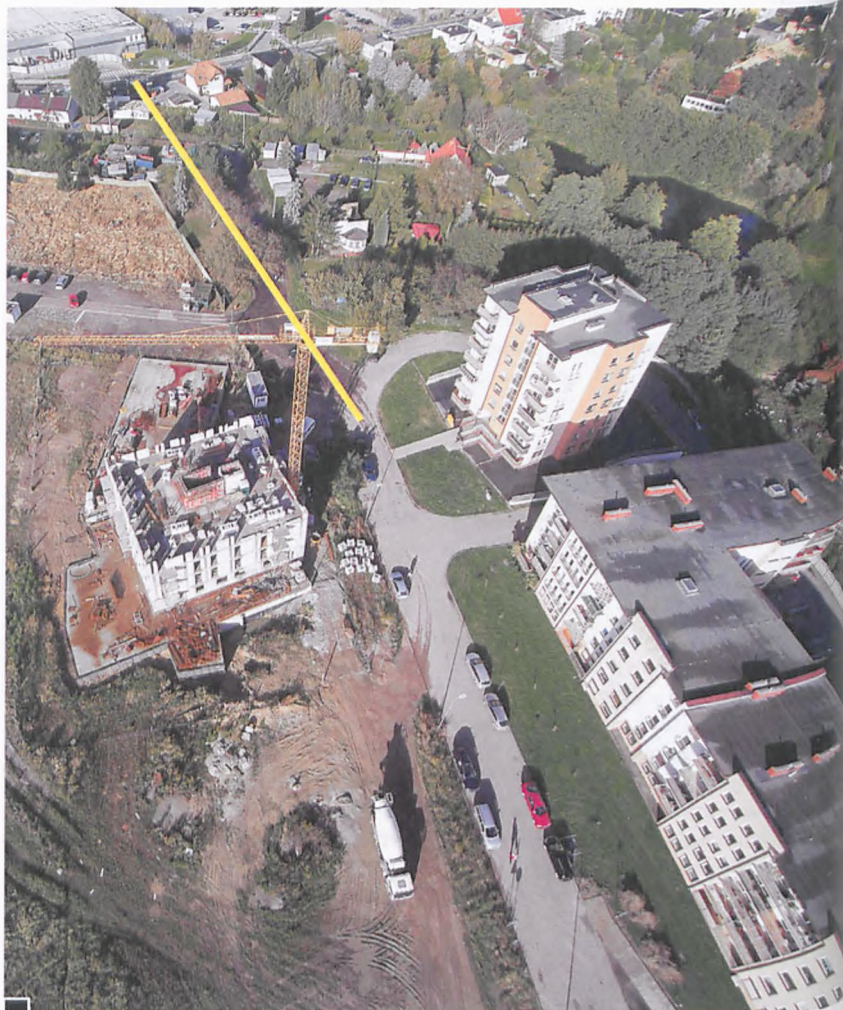
Z lewej – inwestycja mieszkaniowa firmy deweloperskiej M45 przy al. Jana Pawła II – przyszły 7-kondygnacyjny blok z podziemną halą garażową. Z prawej oddany w 2012 r. „punktowiec” z nr 3. Za nim, w głębi, staw, do którego wjazd już jest w posiadaniu miasta. Żółta linia to przedłużenie al. Jana Pawła II do ul. Powstańców Wlkp., dotąd nie wykupione przez miasto i bez projektu. Dopiero jego realizacja nada sens nowemu rondu na ul. Pułaskiego fot. Rafał Wojtyniak
