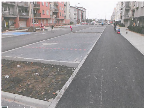
Utwardzona aleja Jana Pawła II – widok od ul. Konarzewskiego. Od lewej – podobnie jak na ul. Wschodniej, 6-metrowej szerokości jezdni (wymiar jak dla drogi lokalnej); pas z prostokątnymi miejscami postojowymi i stanowiskami zieleni; ścieżka rowerowa i chodnik fot. Hanna Siatka
