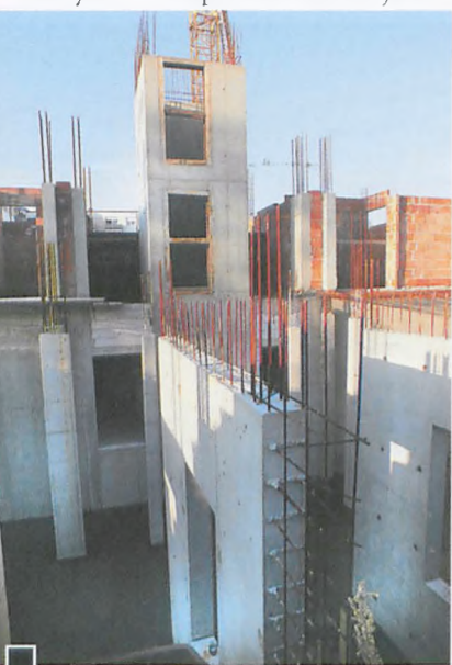
Wstrzymana po raz kolejny budowa bloku przy ul. Wschodniej 19. W przyszłej, niezabezpieczonej, podziemnej hali garażowej gromadzi się woda. Hala ma być dwupoziomowa z ruchomymi platformami dla aut. Budynek „wyszedł” już z ziemi. Widać konstrukcje szybów dla wind fot. Hanna Siatka
