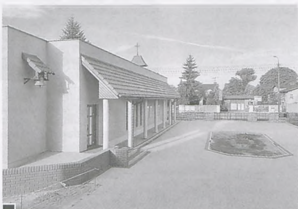
Pięknie nasza świątynia i jej otoczenie. Trwają prace związane z montowaniem kostki brukowej wokół kościoła fot. Anna Kaźmierczak
