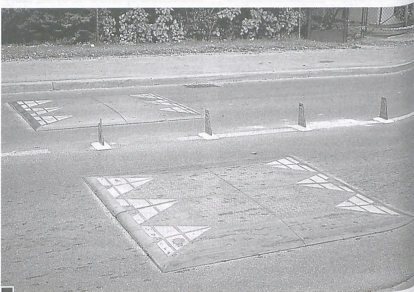
Tablice uchyłne pomiędzy progami wyspowymi na ul. Jesionowej w Poznaniu fot. Rafał Wojtyniak
