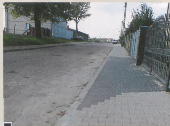
Widok nowego chodnika na ul. Niezłomnych, w kierunku ul. Kościuszki. Z lewej – Muzeum Martyrologiczne. Chodnik wykonano z szarej kostki brukowej, we wjazdach na posesje – ciemniejszej fot. Hanna Siatka
