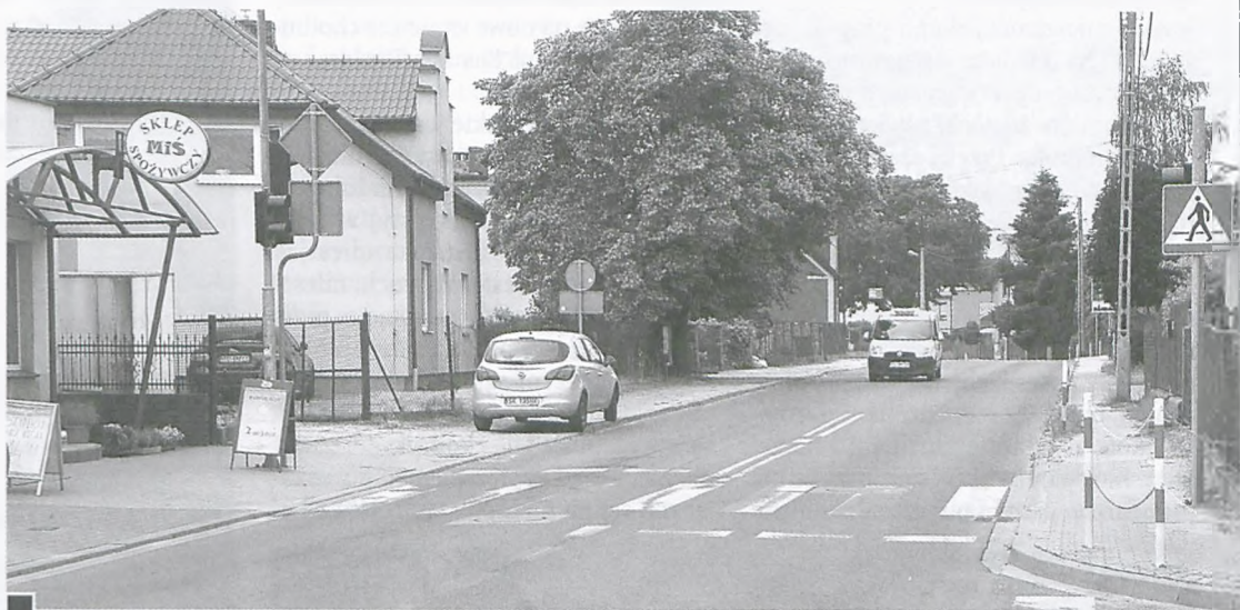
Niezrealizowana obietnica - kilkudziesięciometrowy fragment obustronnego chodnika na ul. Krętej i Laskowskiej, który miał być wykonany w ramach budowy obwodnicy Poznańska Polna Kręta fot. Piotr P. Ruszkowski
