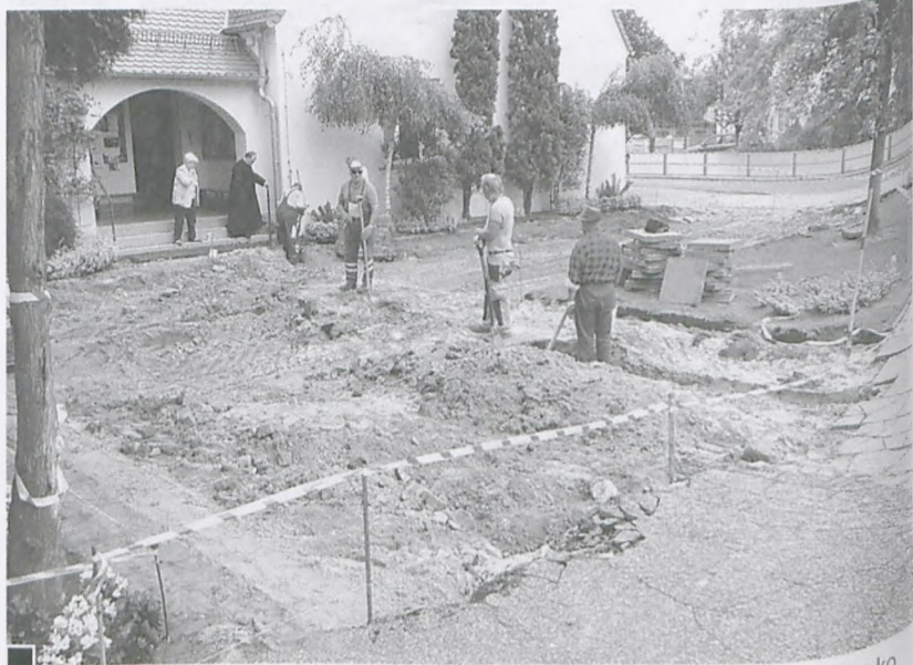
Początek prac przy przebudowie placu przed kościołem św. Barbary. „Pańskie oko konia tuczy” – ks. proboszcz systematycznie dogląda stan prac fot. Hanna Siatka
