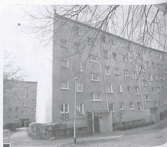
Do połowy mieszkań w bloku przy ul. Żabikowskiej 48 odcięto dopływ gazu z uwagi na nieodpowiedni system wentylacji fot. Hanna Siatka
