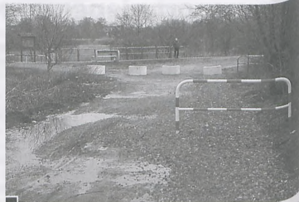
Wysypane drobnym tłuczniem dojsćie nad Staw Edy. W głębi betonowe kręgi zagradzające wjazd na ścieżkę turystyczną, z lewej - jedna z ustawionych niedawno tablic tematycznych fot. Hanna Siatka
