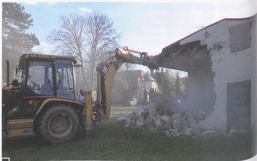
Burzenie salek katechetycznych rozpoczęto od zaplecza w stronę budynku sióstr służebniczek (w sali głównej oraz na zapleczu – tam, gdzie były murowane schody) fot. Rafał Wojtyniak
