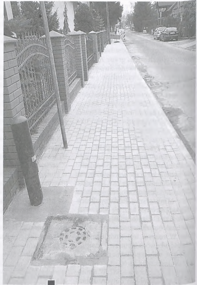
Nowy, pozbrukowy chodnik na ul. Sienkiewicza, od ul. Kościuszki do ul. Przejazd. Przydałby się jeszcze remont asfaltowej jezdni fot. Hanna Siatka
