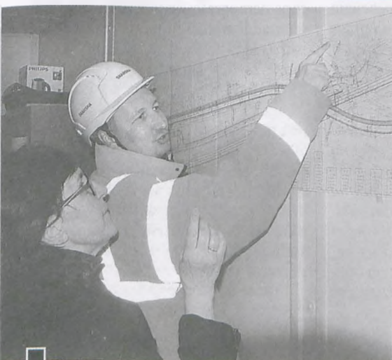
Kierownik budowy tłumaczy nam system komunikacyjny na budowanym węzle fot. Piotr P. Ruszkowski
