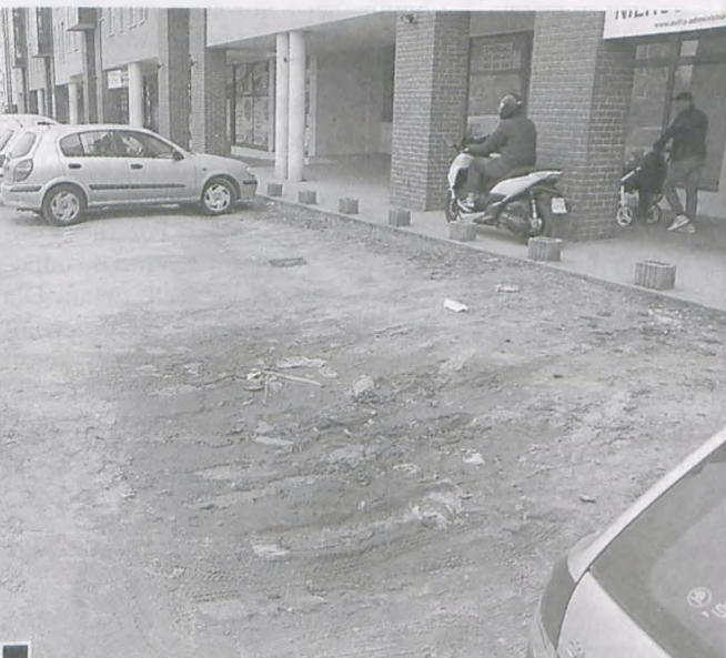
Straszny stan błotnistej parkingu przy ul. Andrzeja Mizerki w Nowym Centrum Lubonia. Niektóre placówki usługowe na własną rękę prowizorycznie utwardzają miejsca przed swoimi lokalami, z których korzystają również mieszkańcy fot. Piotr P. Ruszkowski
