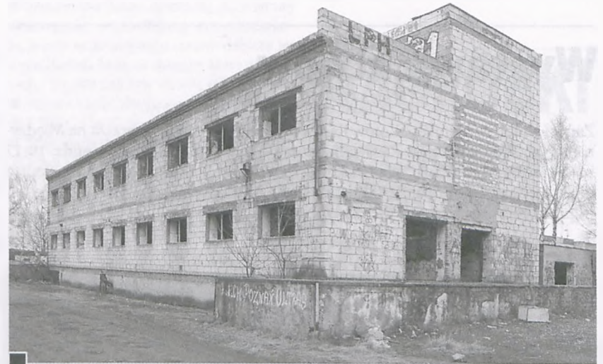
Zdewastowany budynek dawnej firmy przetwórczej „Inter-smak” (z lat 90.) przy ul. Zielonej, należącej do Bogdana Skórczyńskiego. Dziś, z uwagi na nieograniczony dostęp, służy jako miejsce spotkań i różnych środowisk, głównie młodzieży fot. Jan Błaszczak
