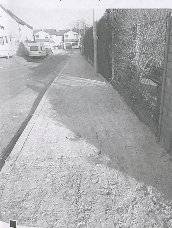
■ Nowo powstały chodnik wzdłuż gruntowej ul. Wiosennej (boczna od Szkolnej) fot. Hanna Siatka
