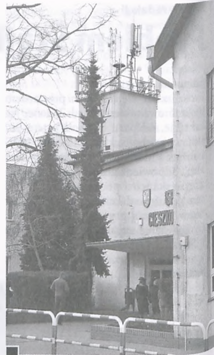
W bezpośrednim sąsiedztwie SP 2 znajduje się remiza OSP, wieżę której wykorzystano jako maszt dla anten telefonii komórkowej fot. Piotr P. Ruszkowski
