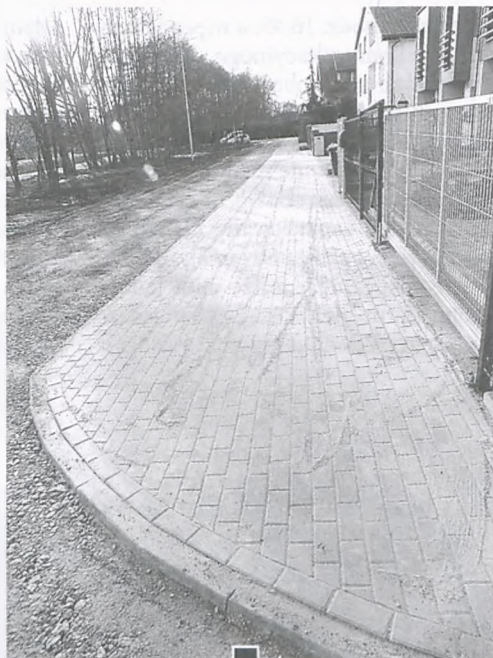
■ Świeżo wykonany chodnik w ul. Jesiennej fot. Hanna Siatka
