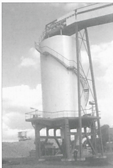
Środa Wielkopolska, składowisko buraków i nowy silos na wysłoki
