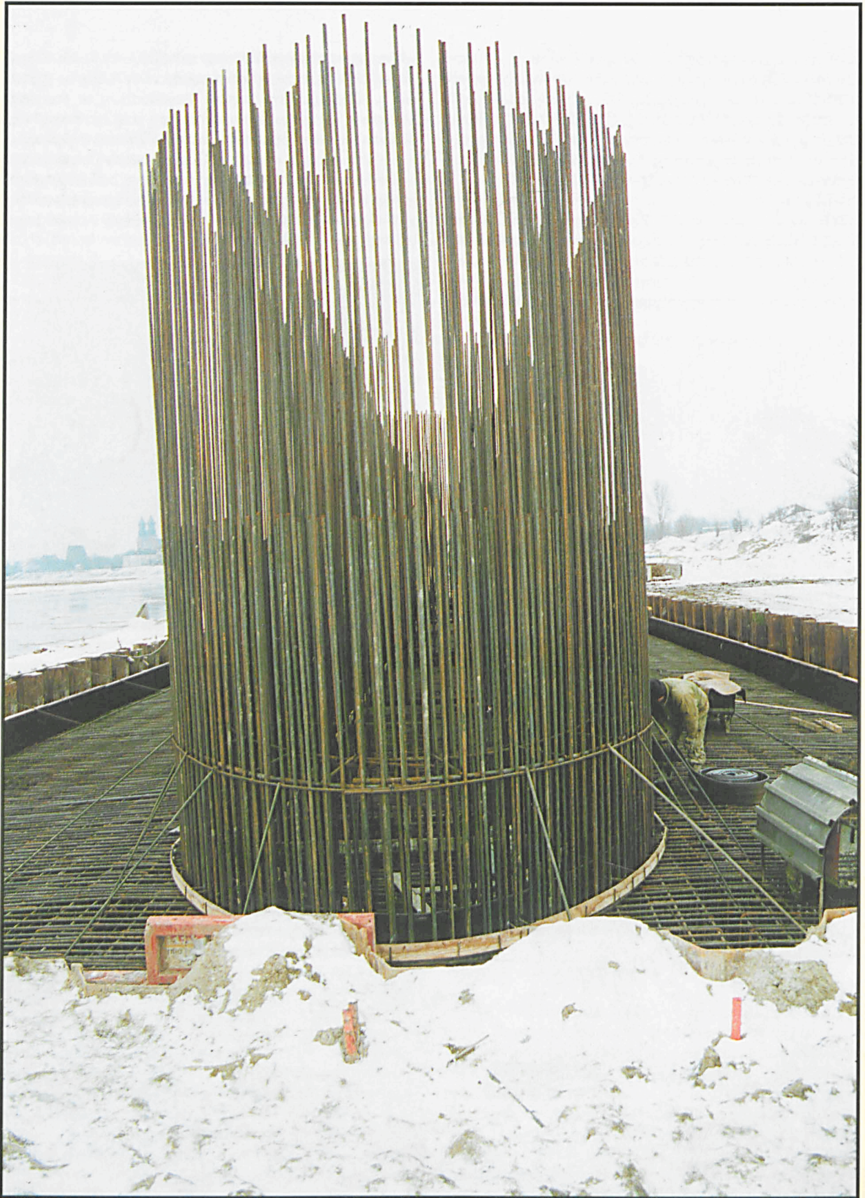
MOST ŚW. ROCHA W POZNANIU W BUDOWIE
