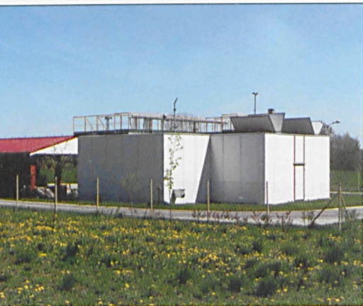
Oczyszczalnia ścieków w Grzebienisku obsługuje wschodnią część gminy.
