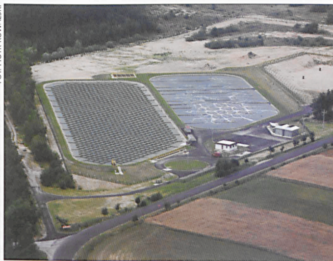
Oczyszczalnia w Powidzu.
