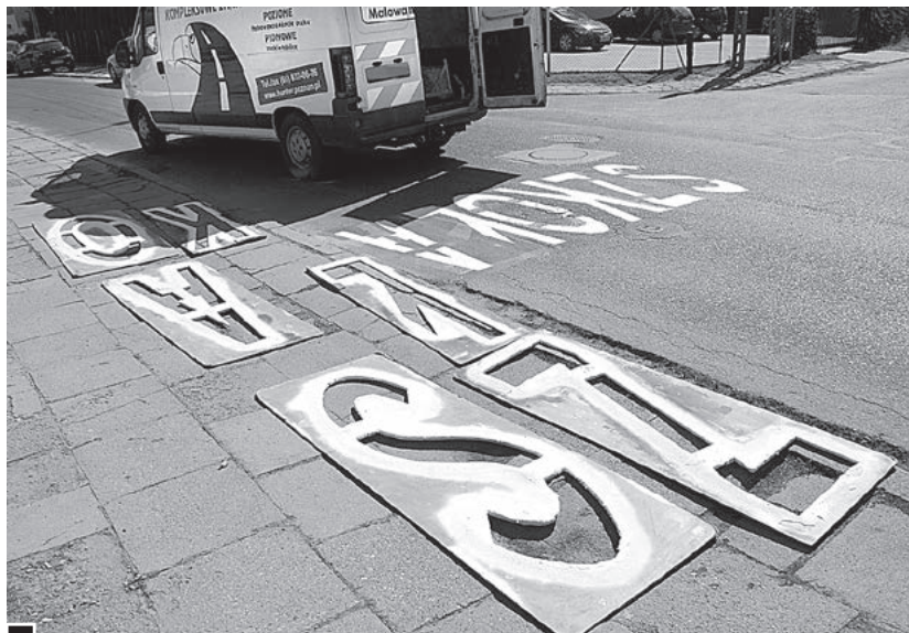
31 sierpnia po południu odnawiano przejścia dla pieszych i napisy SZKOŁA przy SP 3 na ul. Dąbrowskiego
