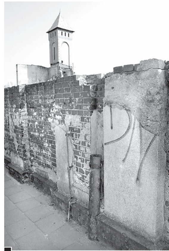
Ni pies, ni wydra – ogrodzenie, resztki zabytku (pozostałości muru po krochmalni II Zakładów Ziemniaczanych, rozebranych dokładnie przed 10 laty (patrz: „WL” 09-2006, str. 5) fot. Piotr P. Ruszkowski
