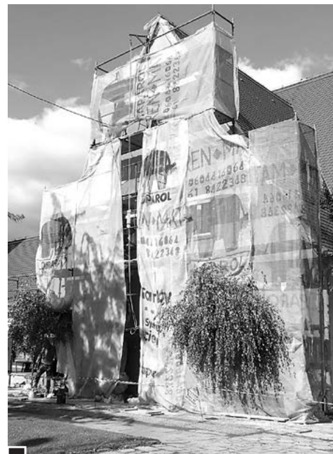
Remont elewacji budynku plebanii parafii św. Barbary fot. Hanna Siatka
