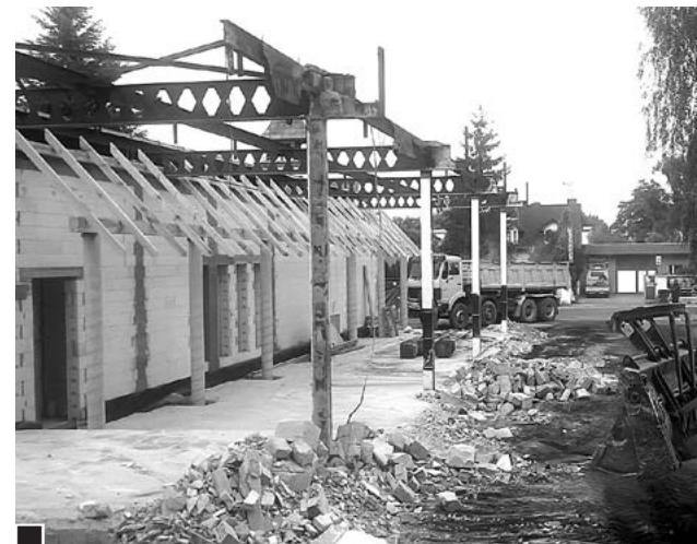
W okresie wakacyjnym trwały zaawansowane prace (sierpień) przy przebudowa starego kościoła na dom parafialny
