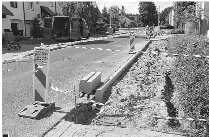
Budowa chodnika na ul. Sienkiewicza – Szkolnej fot. Hanna Siatka
