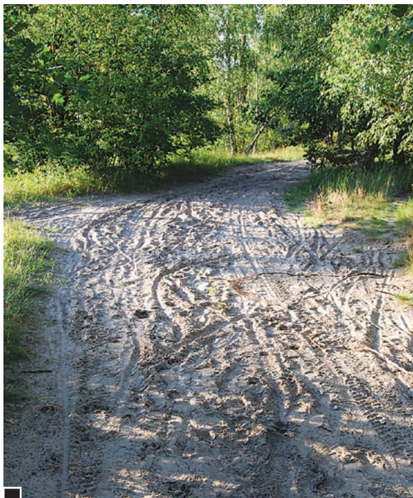
Przykłady nazbyt piaszczystej nawierzchni na lubońskim odcinku trasy rowerowej z Lubonia do Puszczykówka. Odcinki takie warto wyłożyć nawierzchnią z tłuczniem – odzyskiem z ul. Wschodniej fot. Piotr. P. Ruszkowski
