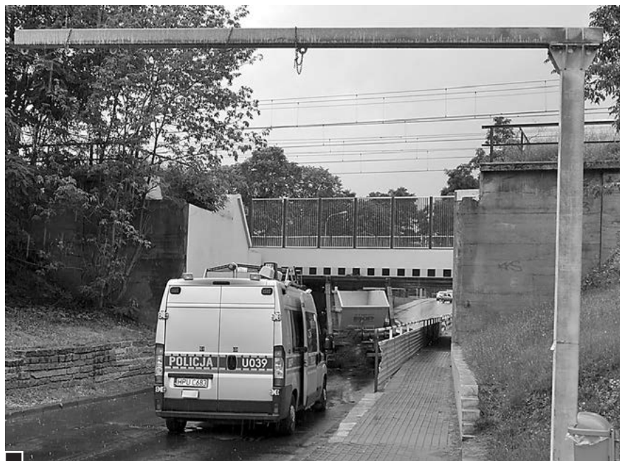
Interwencja policji po kolizji ciężarówki z wiaduktem kolejowym. Na pierwszym planie niekompletne, czyli nie spełniające swojej funkcji urządzenie przed wiaduktem na ul. Powstańców Wlkp., które miało ostrzegać kierowców wysokich pojazdów (pisał o nim kilkakrotnie). Sterczącą konstrukcją w jednoznaczny kształcie złośliwi nazywają już Szubienicą Powstańców fot. Izabella Chodorowska
