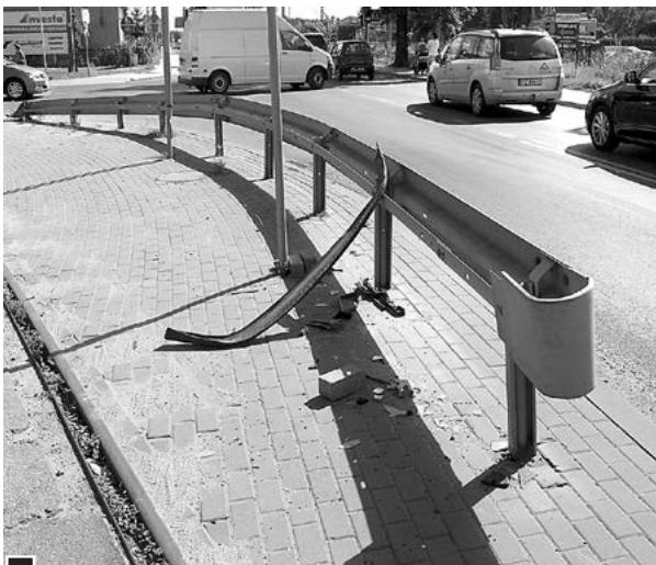
Zalegające na chodniku części pojazdów, które zderzyły się w tym miejscu ponad trzy miesiące temu fot. Paweł Wolniewicz
