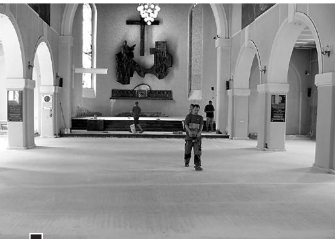
Wylewka keramzytowa przykryła instalację ogrzewania podłogowego fot. Paweł Wolniewicz
