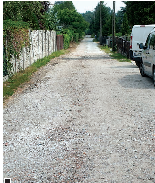
Po uzbrojeniu dróg w kanalizację, gruntowe drogi w Lasku zostały wysypane tłuczniem przez Aquanet. Na zdjęciu ul. Dojazdowa fot. Hanna Siatka
