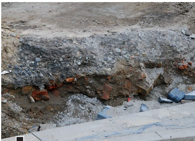
Kilkudziesięciocentymetrowa warstwa dotychczasowej nawierzchni ul. Wschodniej i alei Jana Pawła II w Nowym Centrum Lubonia zawiera gruz, tłuczeń oraz pofrez asfaltowy i może być powtórnie wykorzystana na dostatecznie dobre nawierzchnie dotychczas piaszczystych lub błotnistych odcinków tras rowerowych fot. Piotr P. Ruszkowski
