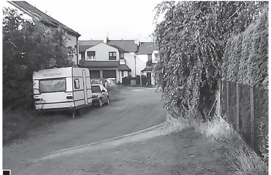
Zwężenie jezdni na skutek zarośnięcia drzewa i parkujących samochodów
