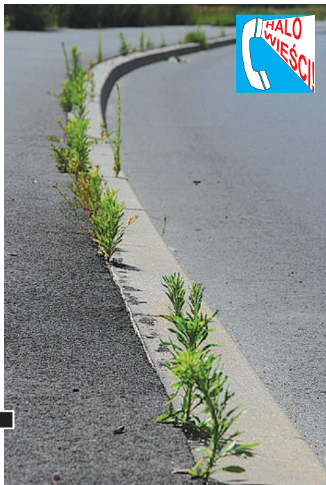
Chwasty w szczelinach pomiędzy krawężnikiem i nawierzchnią bitumiczną chodnika na ul. Polnej fot. Piotr P. Ruskowski
