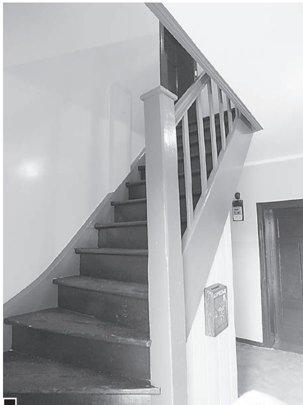
Odremontowane schody, poręcz i klatka schodowa fot. Hanna Siatka
