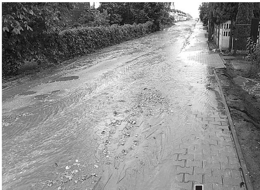
Podczas ulewy woda, na skutek nagromadzonej ziemi, którą niesie, przelewa się przez chodnik na posesję przy ul. Kurowskiego
