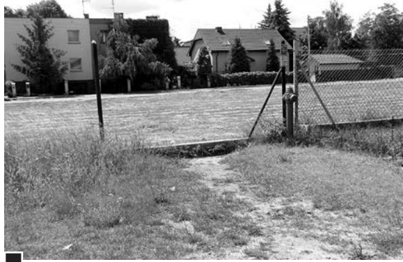
Tędy przebiega wydzielony pas drogowy do ul. Łącznej (ta – w głębi). Przez niekompletne ogrodzenie, kierując się w prawo, przez prywatne pole mieszkańcy Malinowej docierają do sklepów i na przystanek. Ci, co poruszają się na rowerach, przenoszą pojazdy przez podmurówkę fot. Hanna Siatka
