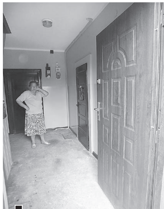
Nowe, solidne drzwi wejściowe. Poprzednie, pokazywane przez nas m.in. w kwietniu 2014 r. były spróchniałe, mocno zniszczone i nieszczelne fot. Hanna Siatka
