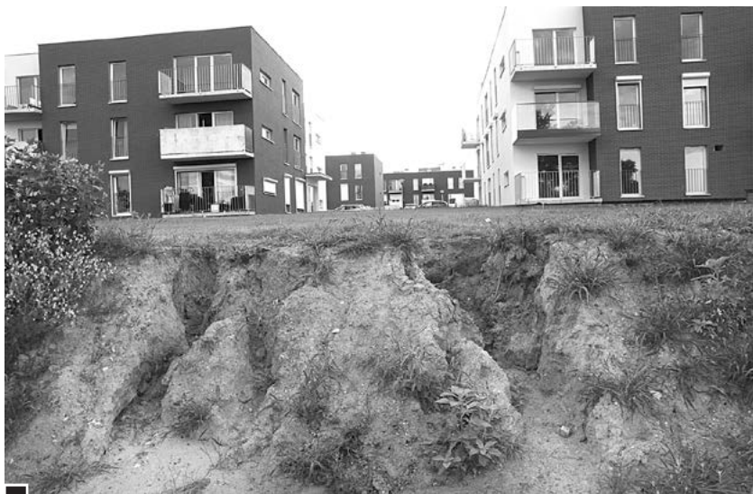
Skarpa trawnika na osiedlu Warta Park zniszczona po ulewach fot. Piotr P. Ruszkowski
