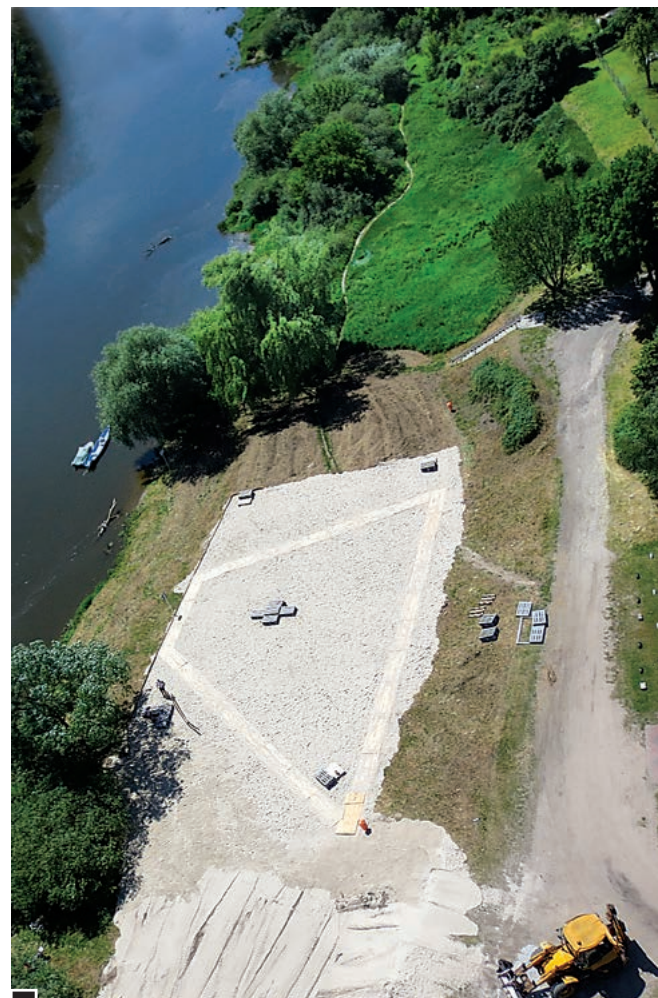
Zdjęcie plaży miejskiej z lotu ptaka wykonane w przeddzień otwarcia. Wyraźnie widać jak piaskiem i drewnianymi podestami, wbrew projektowi przykryto, a więc przerwano istniejącą trasę dydaktyczno-rowerową, prowokując bardziej do przekleństw niż relaksu fot. Rafał Wojtyński
