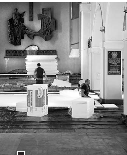
Nazajutrz po niedzieli, 11 lipca, układa się folię izolacji wilgotnościowej, instalację kablową oraz 10-centymetrową warstwę ocieplającą styropianu (2x5 cm) fot. Piotr P. Ruskowski
