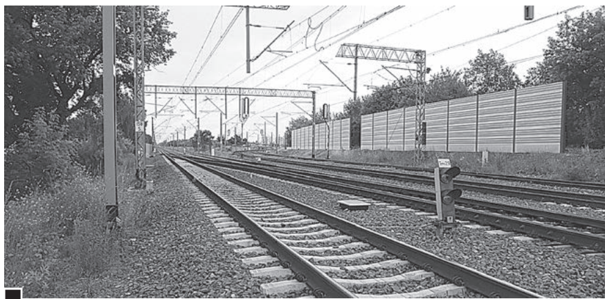
Zastosowane jednostronnie i tylko fragmentarycznie ekrany akustyczne przy torach wzdłuż ul. Rivoliego nie tylko nie wytłumiły hałasu, ale, zdaniem mieszkańców, go wzmacniają fot. Piotr P. Ruszkowski
