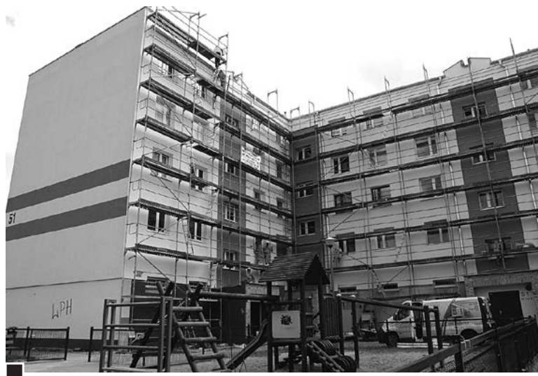
Termomodernizacja ścian bloku przy ul. Sikorskiego 51 od strony osiedla fot. Piotr P. Ruskowski
