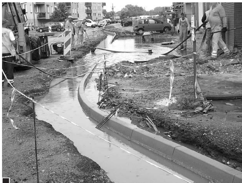
Odpompowywanie wody przy budowanym rondzie w NCL fot. Hanna Siatka
